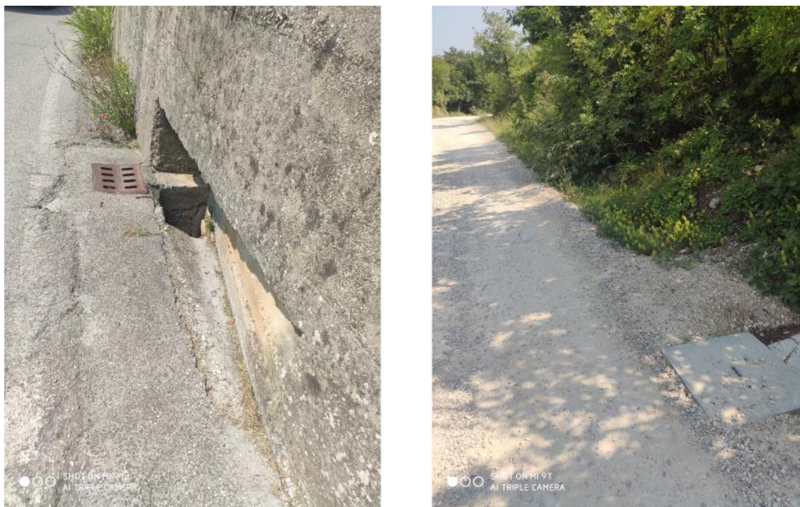
Figura 2.7. Immagini di pozzetti stradali a servizio della cunetta lungo via Monte della Croce, nel tratto di valle asfaltato (a sinistra) e nel tratto di monte sterrato (a destra)
