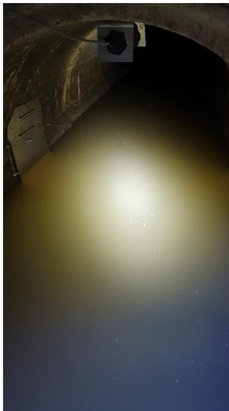
Figura 2-8: Misuratori di livello e velocità SO01C al momento dell'installazione.
