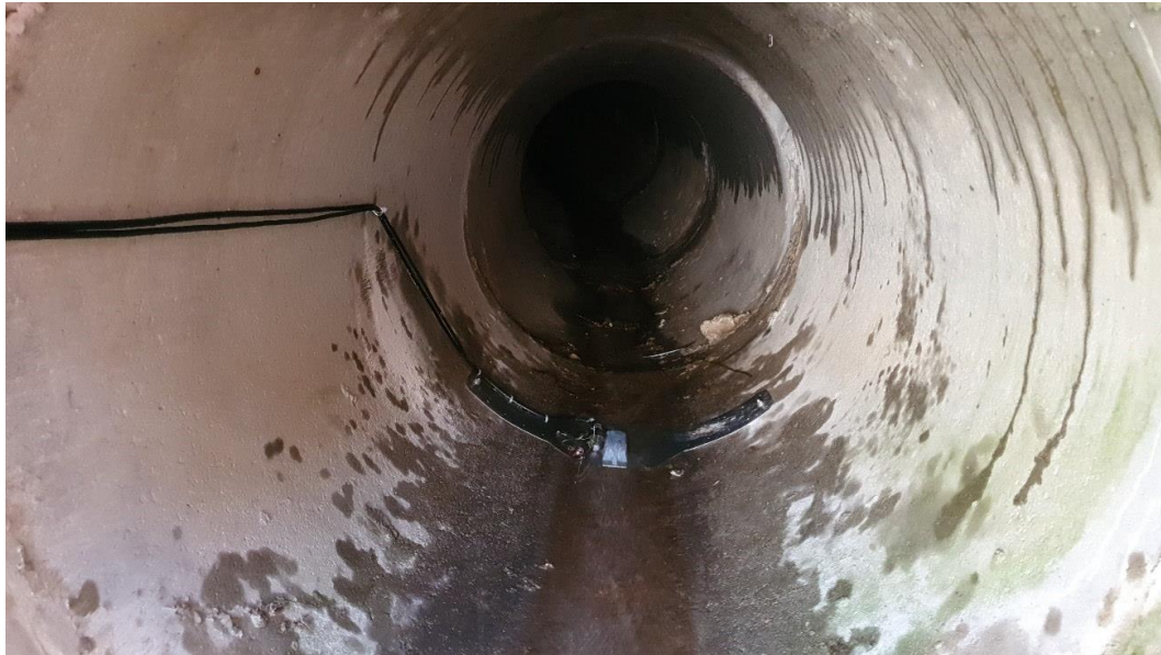
Figura 2-10: Misuratori di livello e velocità SO02A al momento dell'installazione.
