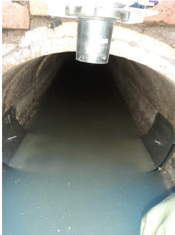
Figura 2-5: Misuratori di livello e velocità SO01B al momento dell'installazione.
