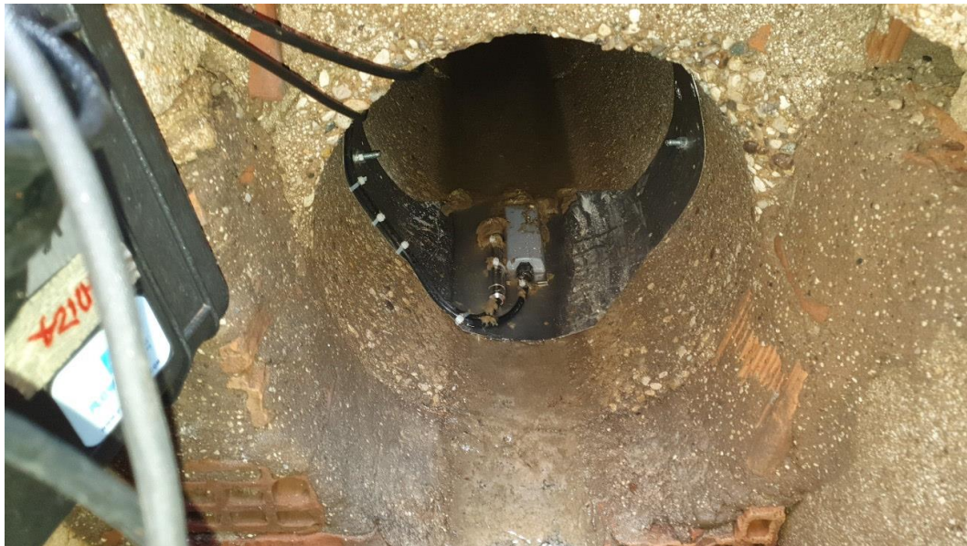
Figura 2-3: Sensori di livello e velocità al punto di misura SO03 al momento dell'installazione.
